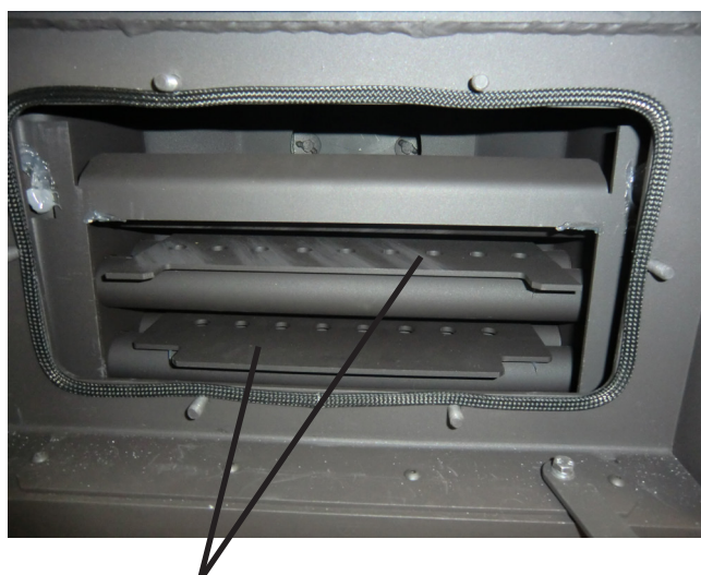
Fig. 6 Warmtewisselaar-platen
